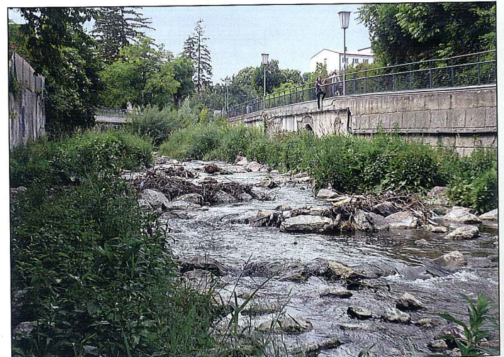
Abb. 2: Blocksteinrampe und Weidenflechtzaun am revitalisierten Abschnitt des Mödlingbaches auf der Höhe des Realgymnasiums Keimgasse (2008). Fig. 2: Rampe en enrochements et tunage de près sur le tronçon revitalisé du Mödlingbach sur les hauteurs du gymnase de Keimgasse (2008).
