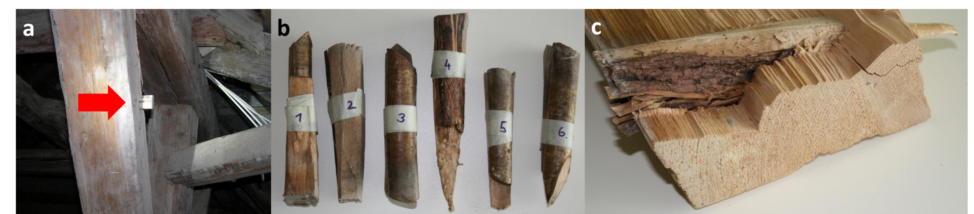
Abb. 4: Flößerkeile a: Flößerkeil im Dachstuhl Objekt Bockfließ (Foto S. Karanitsch-Ackerl), b: Flößerkeile Objekt Bockfließ (Foto R. Stingl), c: Flößerkeil Demonstrationsobjekt (Foto R. Stingl)
