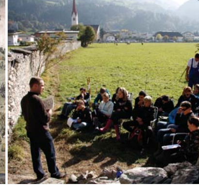
Umfassungsmauer von Schönwerth, Schadensbild 2010
